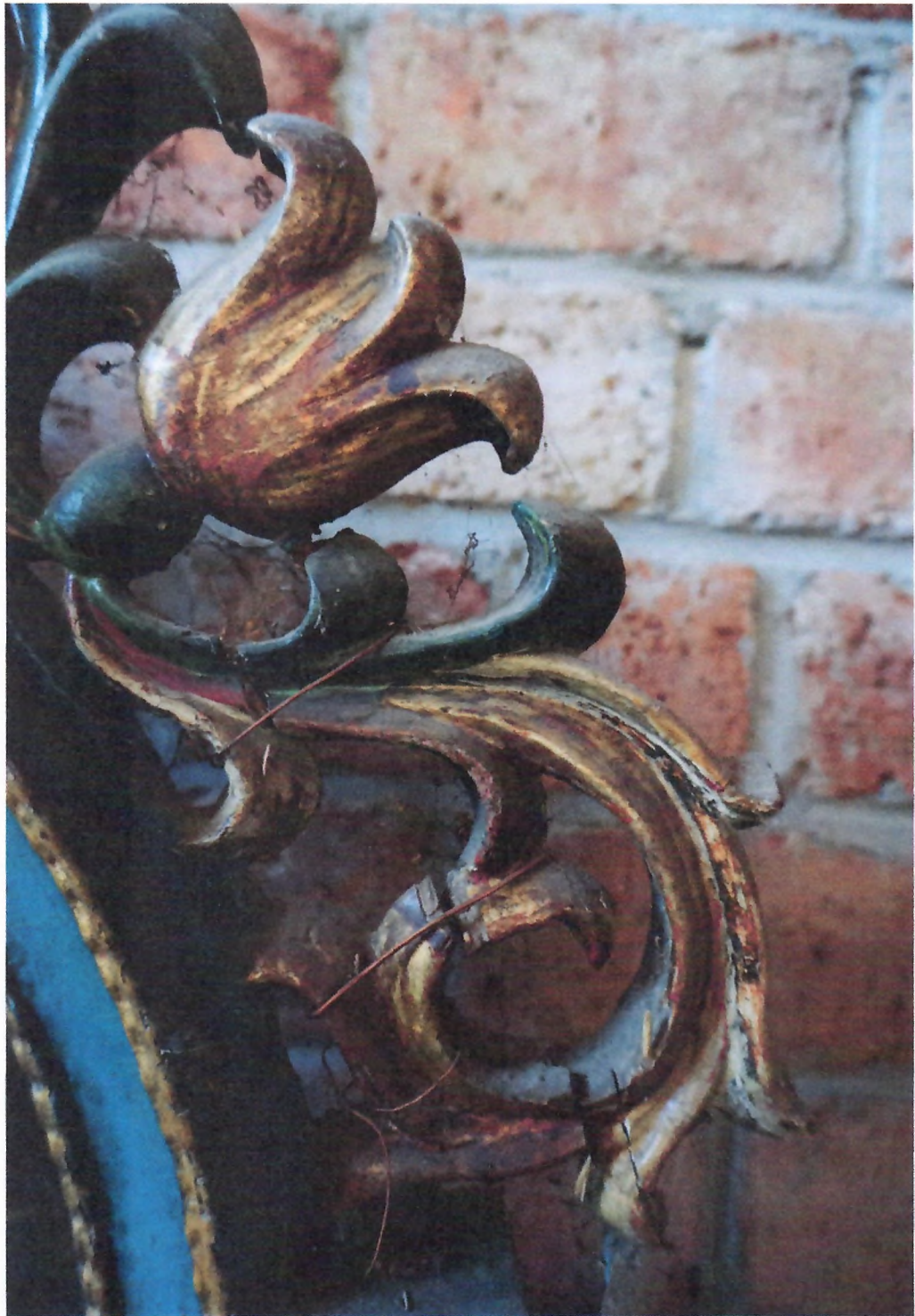
Fot. 12 Snycerskie obramienie feretronu z obrazami Anioł Stróż i Św. Michał Archanioł (1669 r.), z kościoła pw. św. Michała Archanioła w Binarowej, obecnie w Muzeum Parafialnym. Widoczne bardzo silne zabrudzenie oraz odpajające się od drewnianego podłoża nawarstwienia technologiczne. Laserunki oraz partie polichromowane zostały częściowo poddane retuszom w XX w. Elementy snycerskie noszą ślady licznych uszkodzeń mechanicznych i drobnych ubytków formy.
